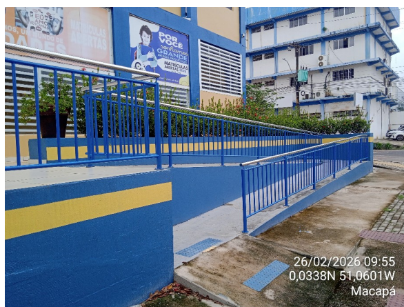
Foto 06 – Rampa de acesso para cadeirantes.
